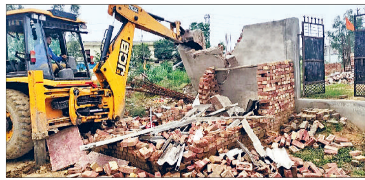
बहादुरगढ़। कसार के निकट निर्माण ढहाती डीटीपी की जेसीबी।
